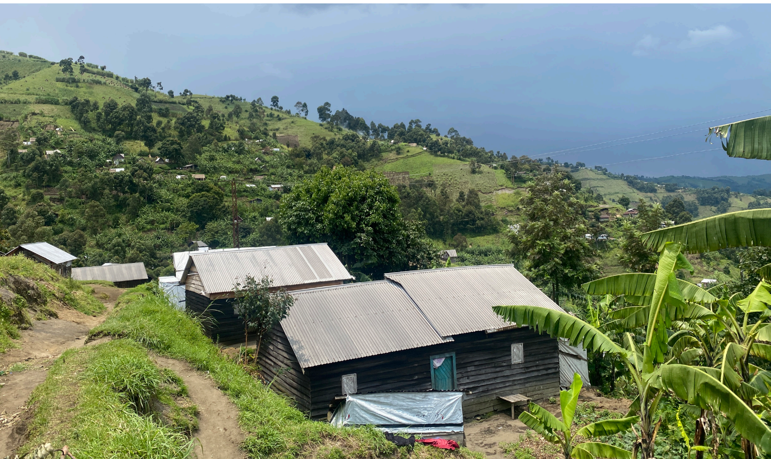
Figure 6 : Vue d'un village après réhabilitation des abris au Nord-Kivu/NRC
